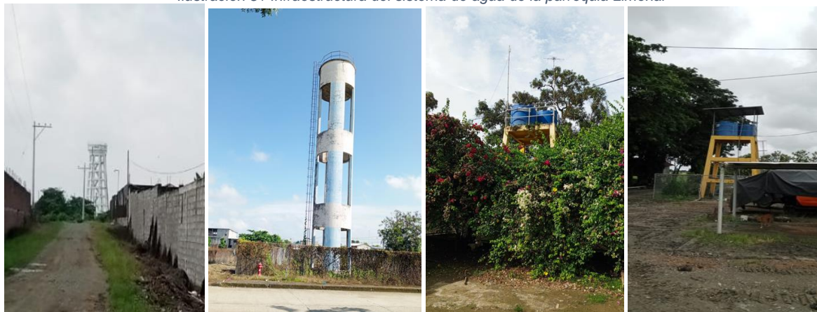
Ilustración 51 Infraestructura del sistema de agua de la parroquia Limonal
