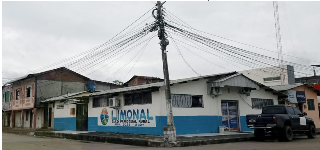
Ilustración 81 Instalaciones del GAD Parroquial Limonal
