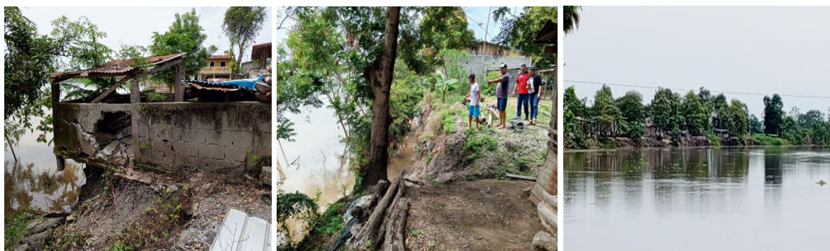
Ilustración 3 Ladera del río Daule a la altura del Recinto Valdivia
