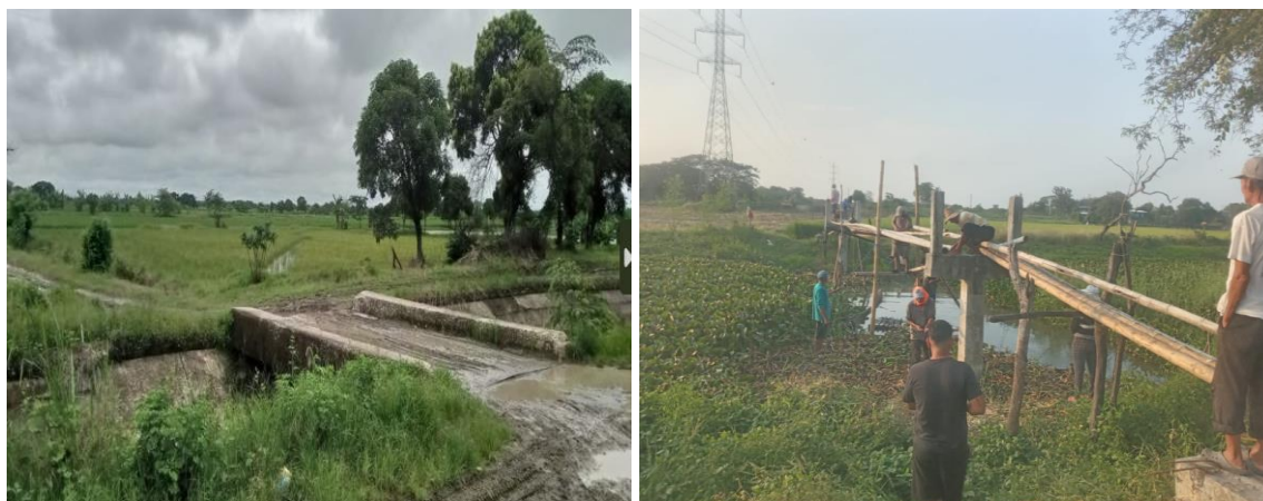
Ilustración 34. Puente Carrozable del Recinto Los Pozos
