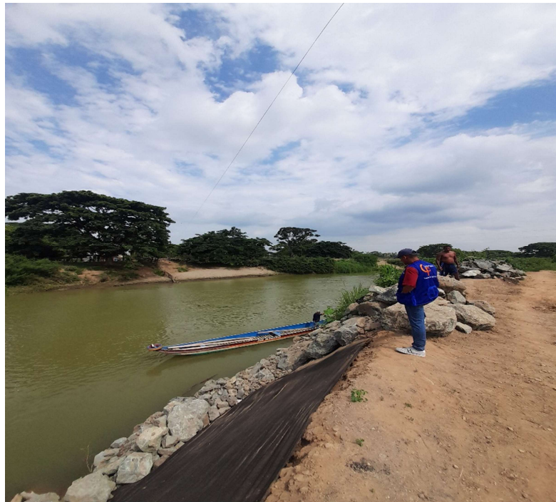
Gráfico 3: Deslizamiento de tierra en la parroquia
